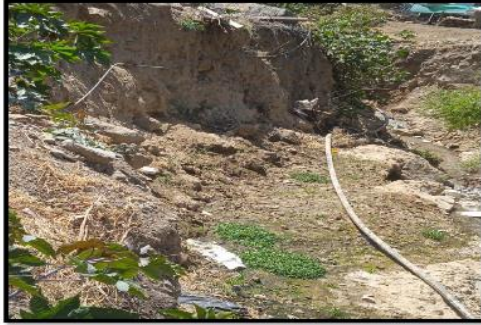
FIGURA 11: TALUDES QUE SOCAVAN POR AVENIDA DE AGUAS POR FUERTES PRECIPITACIONES.
