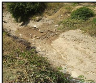
FIGURA 04: DESCOLMATACIÓN DEL CAUSE PARA EVITAR EROSIÓN EN LA TALUD.
