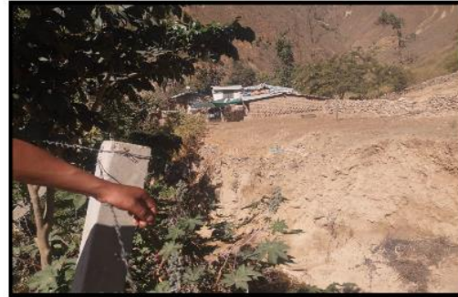
FIGURA 12: SE OBSERVA EROSION Y SOCAVACION DE LA TALUD VIVIENDA EN RIESGO.
