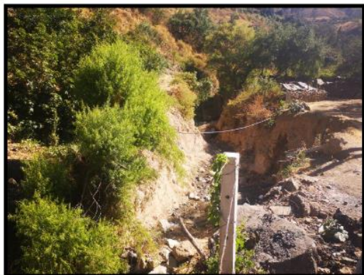
FIGURA 01: LIMPIEZA DEL CAUSE PARA EVITAR DESBORDE Y DAÑOS DE LOS CULTIVOS.
